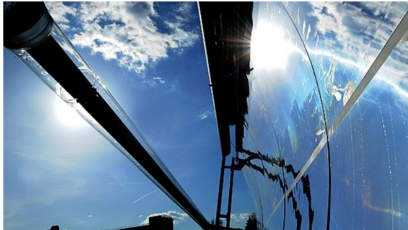
Parabolrinne mit Receiverrohr. Bild: DLR.
